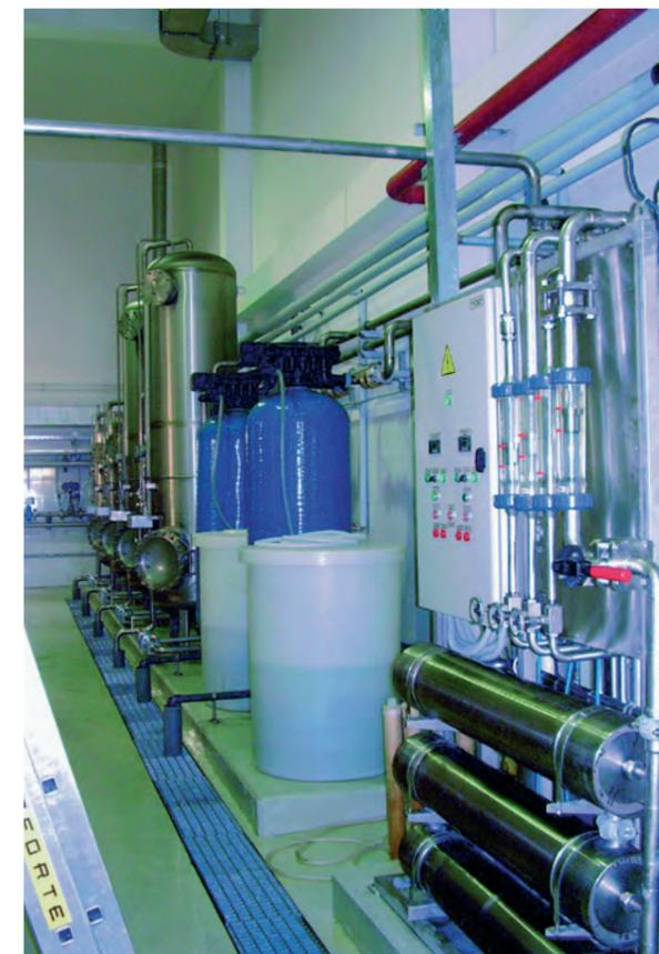
Блочная компоновка оборудования позволяет изготовить блоки непосредственно на заводе и в готовом виде поставить на объект
