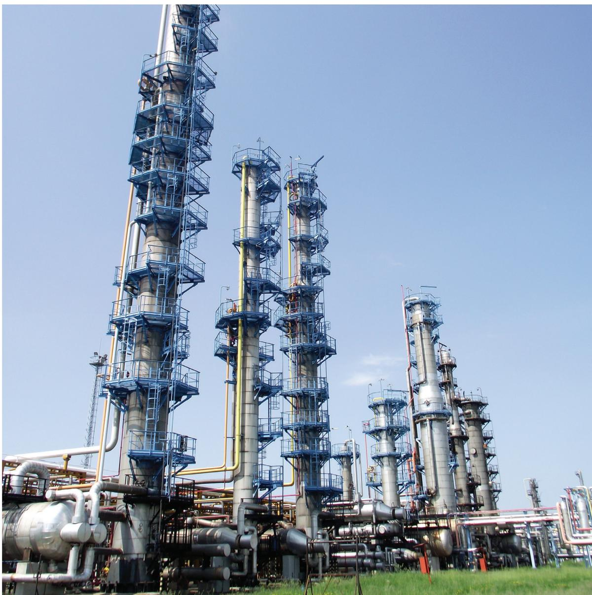
Большинство технологических процессов получения продукции современного уровня качества не обходится без блоков очистки или концентрирования. Ректификация - один из наиболее распространенных и широко используемых способов разделения смесей на компоненты и выделения целевых продуктов.
